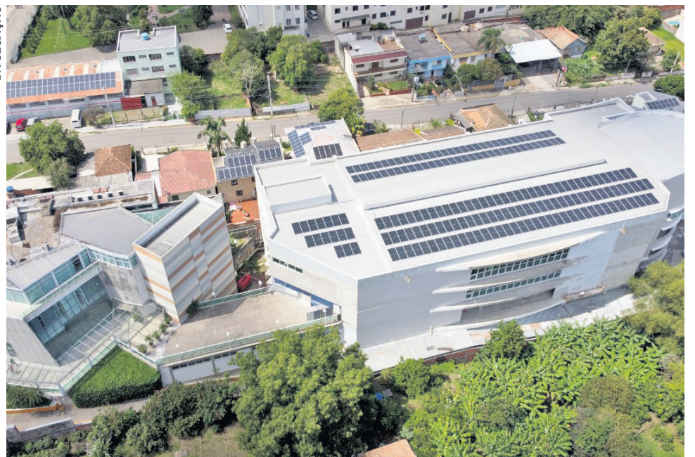
Painéis foram instalados no telhado da associação. Sistema deve gerar economia de R$ 10 mil
