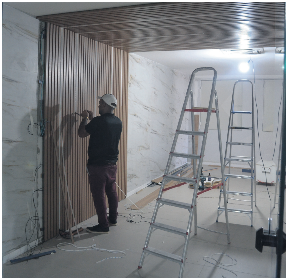
Prestadores de serviços instalaram painel ripado e iluminação embutida no hall do elevador
