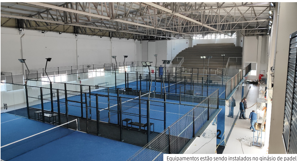
Equipamentos estão sendo instalados no ginásio de padel
